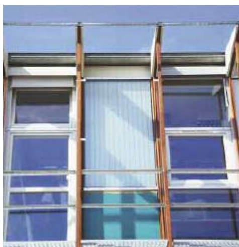
نماهای ساختمانی شفاف با استفاده از آئروژل و کاربرد آزمایشی آن در یک ساختمان (منبع: ZAE Bayern)
